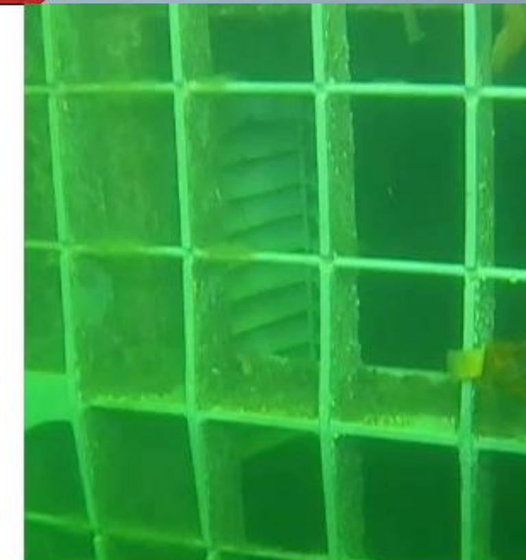
Рисунок 6. Участок жалюзийного экрана РЗУ с противообрастающим покрытием «Эксидис»
